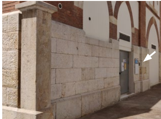
Posten 10: Am Dolderweg 5 an der Wand neben der Infotafel von IWB
