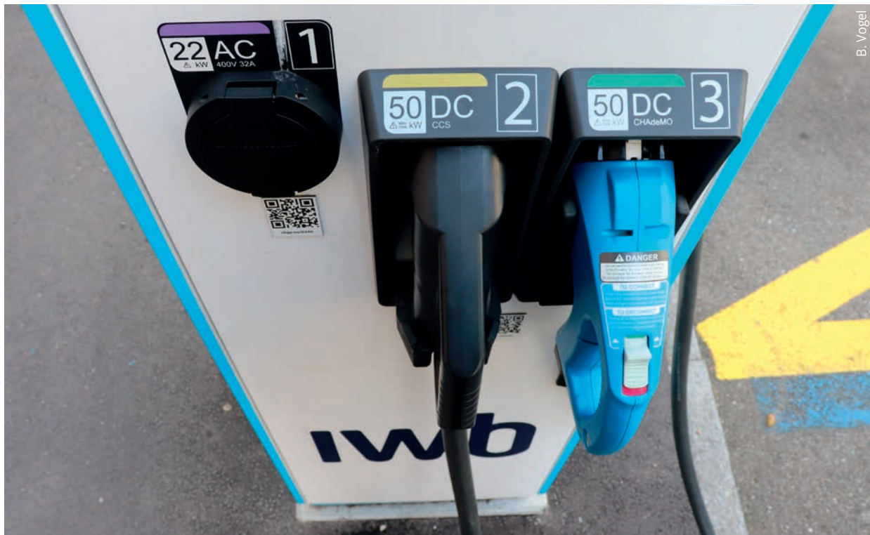
Diese Ladesäule verfügt über drei Ladepunkte: Links die Steckdose mit 22 kW Leistung, rechts zwei «Einfüllstutzen» mit jeweils 50 kW Leistung.
